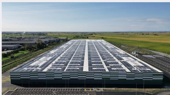
**SAN PIETRO MOSEZZO (NO):** impianto di energia solare fotovoltaica installato a tetto; il progetto ha visto la costruzione di un polo logistico e il relativo impianto su un lastriko solare di circa 70.000 mq. L'impianto presenta una potenza complessiva di 9 MWp.
