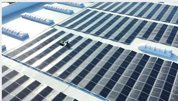
**PASSO CORESE (RI):** impianti di energia solare fotovoltaica installati a tetto; il progetto ha visto la costruzione di un polo logistico. Gli impianti installati sulla copertura degli edifici portano ad ottere una potenza complessiva che supera i 12 MWp, di cui 6 MWp previsti a cessione totale nella rete elettrica nazionale.
